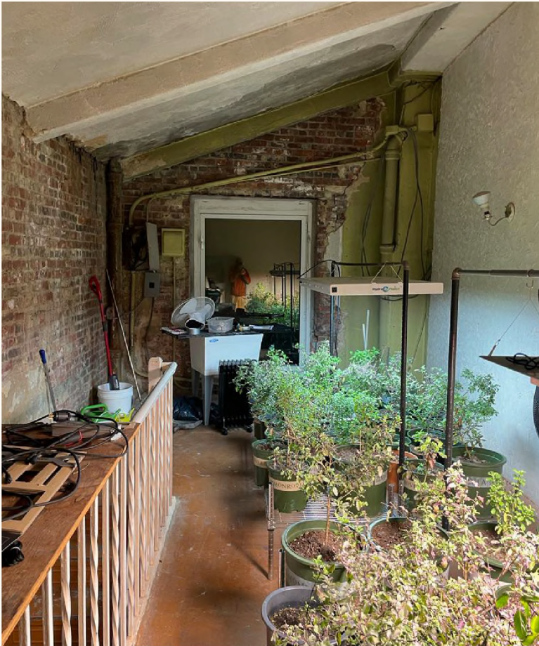
Комната, которую Аиндра отремонтировал для Рамабхадры
